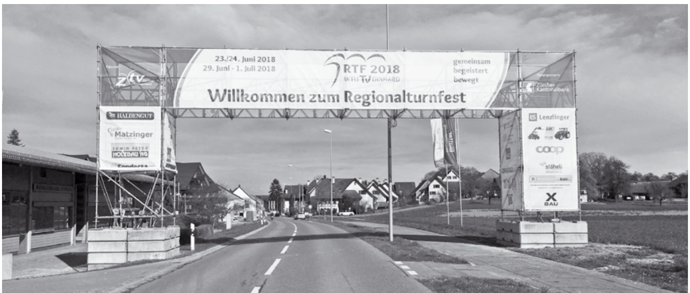
Am 12. April haben Mitarbeiter der Firma X-Bau zusammen mit Helfern des RTF das Festtor über der Welsikerstrasse errichtet. Als spektakulärer Blickfang wirbt es seither für das RTF 2018.
