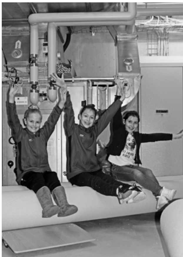
Seraina, Lana und Carina strahlen im Heizungsraum der Turnhalle Dinhard um die Wette.
