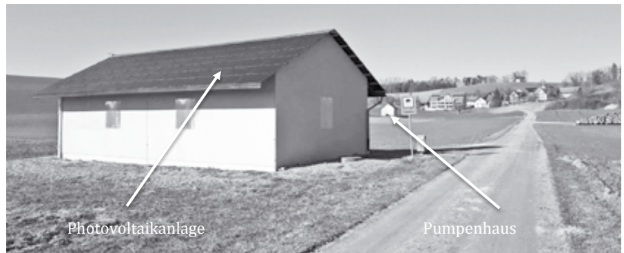
Im Vordergrund die Feldschüür mit der Photovoltaikanlage auf dem Dach, im Hintergrund das Grundwasserpumpwerk Vordergrüt.
