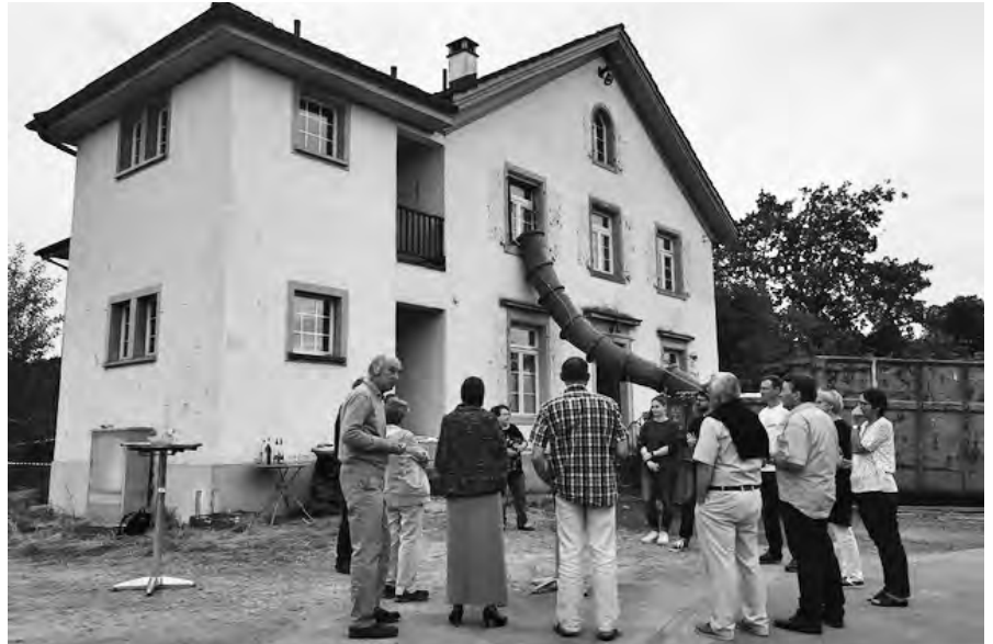
Augenschein der Nachbarn bei der Baustelle Schulhaus Kirch-Dinhard.
