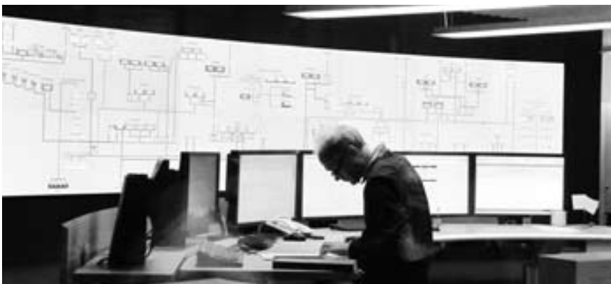
Die Kommandozentrale für die Zürcher Wasserwerke Hardhof, Lengg und Moos.
