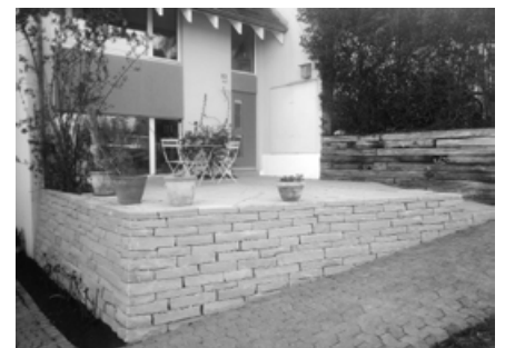
Trockenmauer an der Bühlstrasse
