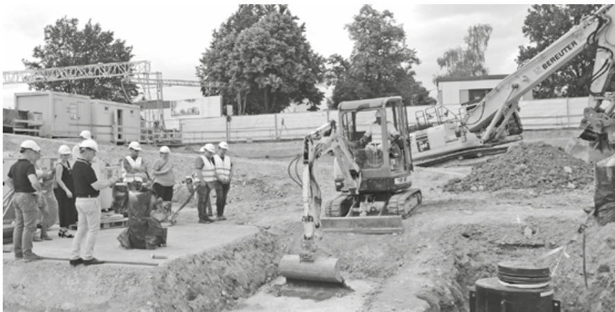
Aushebung der Grube für die Grundsteinlegung
