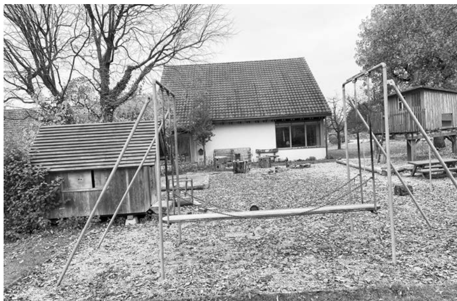
Die sich in schlechtem Zustand befindlichen Spielgeräte auf dem Kindergarten-spielplatz werden ersetzt. Bilder: Peter Mesmer
