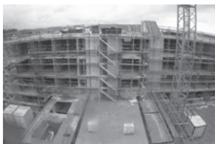
Der Rohbau vom Haus Feld ist erstellt.
