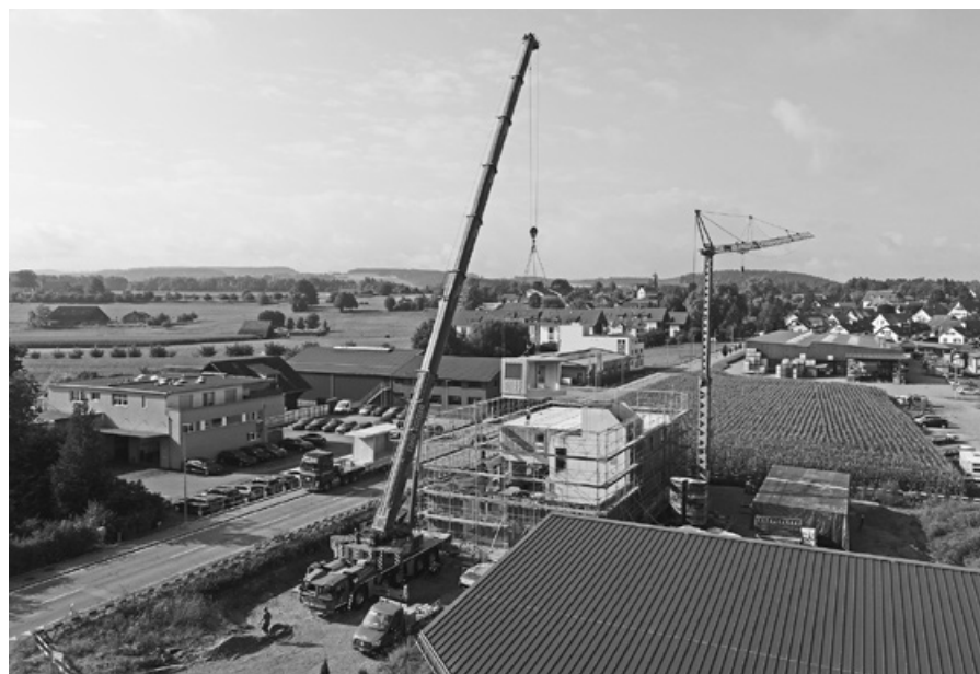
Millimetergenaue Arbeit mit dem riesigen Kran.
