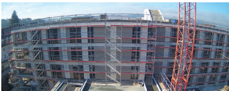
Der Neubau «Haus Feld» ist auf Kurs und sollte im September 2022 fertig sein.
