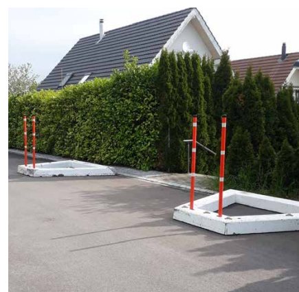
Horizontalversätze an der Buelstrasse. Bild: Otto Ettlin
