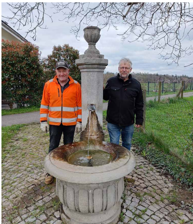
Werkmeister Otto Ettl (links) und Brunnenmeister Kurt Gerber sind für die Wasserversorgung Dinhard zuständig.
