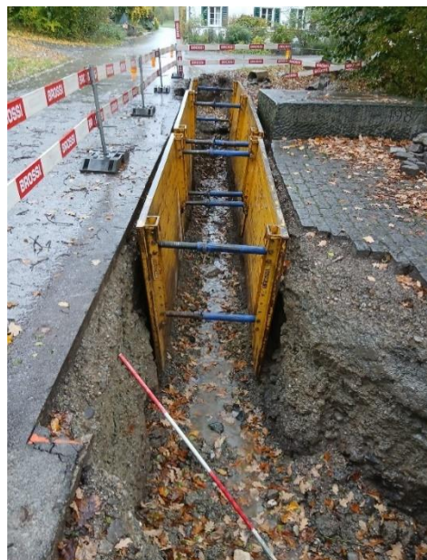
Baustelle in Kirch-Dinhard: Arbeiten am Regenabwasserkanal (Foto: Frank Müller)
