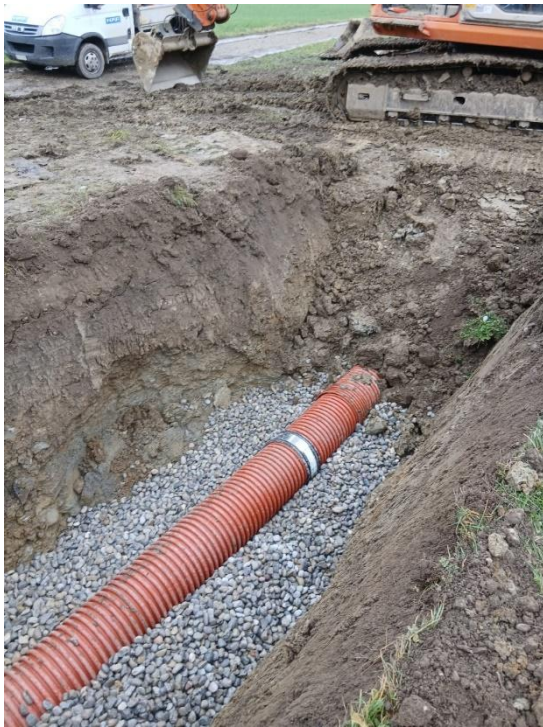
Ersatz Meteorwasserleitung Müliwis (Foto: Frank Müller)
