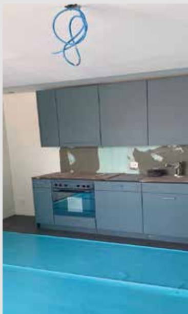
Feinschliff in der Küche der neuen Horträume im Untergeschoss.
