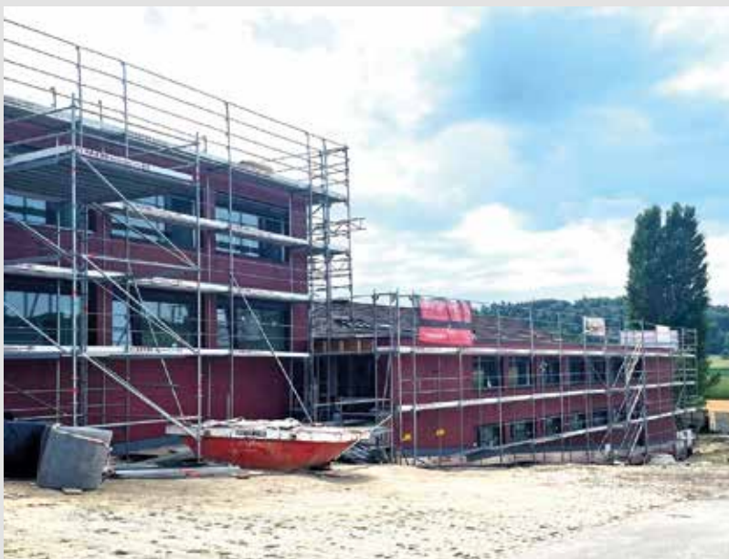
Die moderne rote Fassade noch etwas verdeckt vom Baugerüst.
