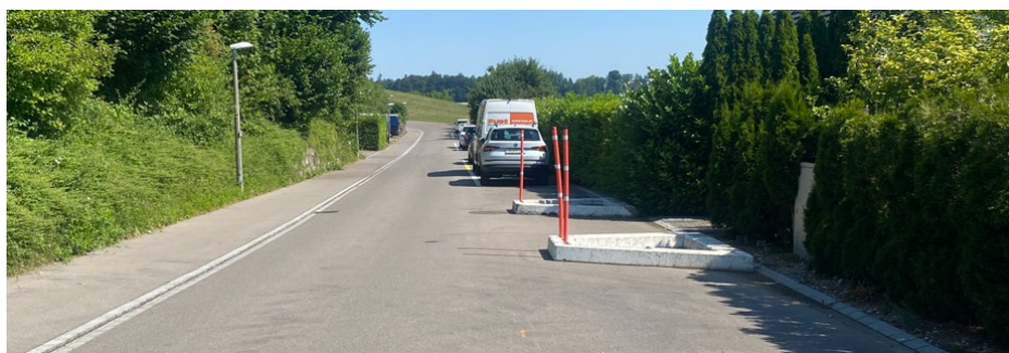
Abbildung 15: Ausgestaltung seitliche Einengung (Fg-Querung Baumgartenweg)
