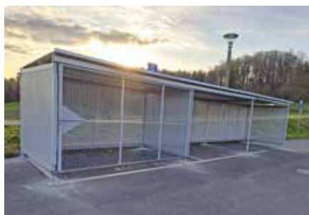
Die Veloabstellanlage wurde vom Bahnhof Dinhard zum Schulhaus versetzt.
